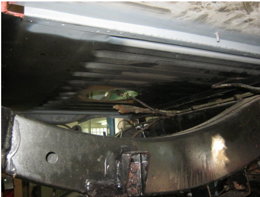
Der Kofferraumboden von unten betrachtet.
